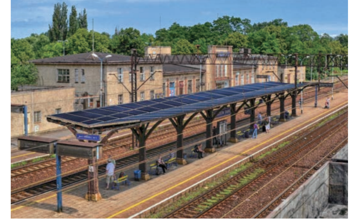
建造物側面全体
